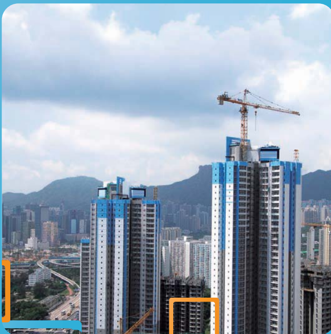
Construction of Choi Wan Road Development Site 2 Phase 1 興建彩雲道2號地盤發展計劃第一期
