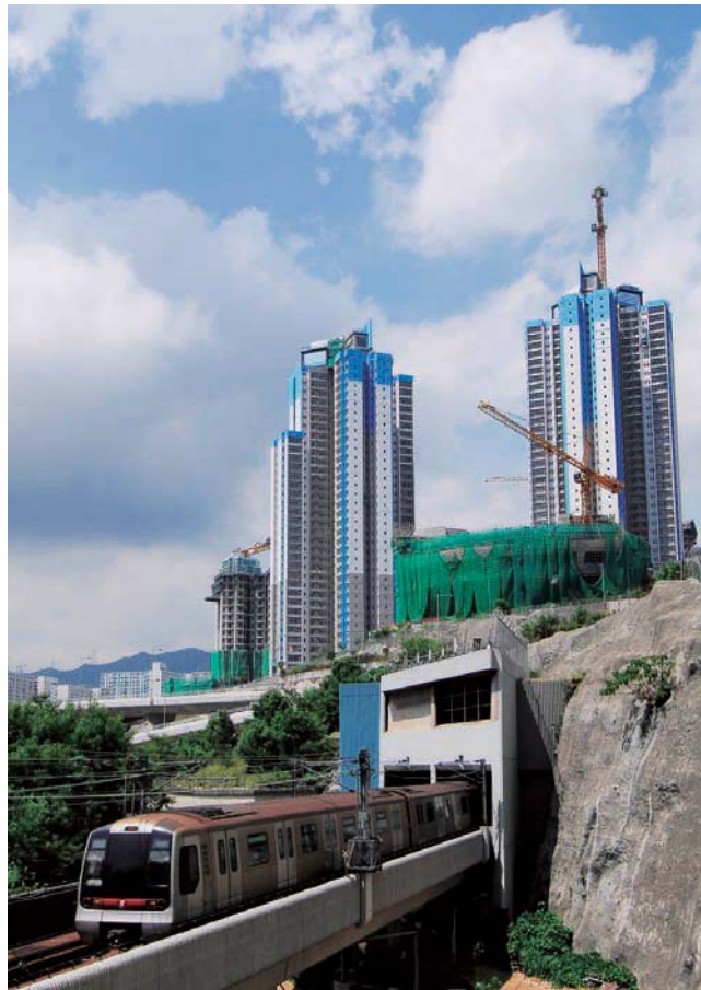
Construction of Choi Wan Road Development Site 2 Phase 1 興建彩雲道2號地盤發展計劃第一期
